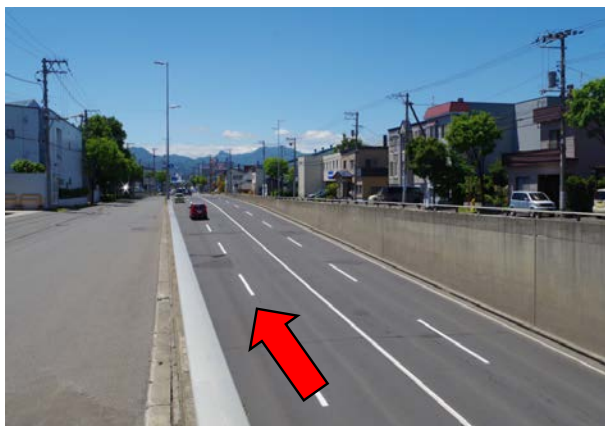
①菊水元町方面より直進し、アンダーパスを越えます。
